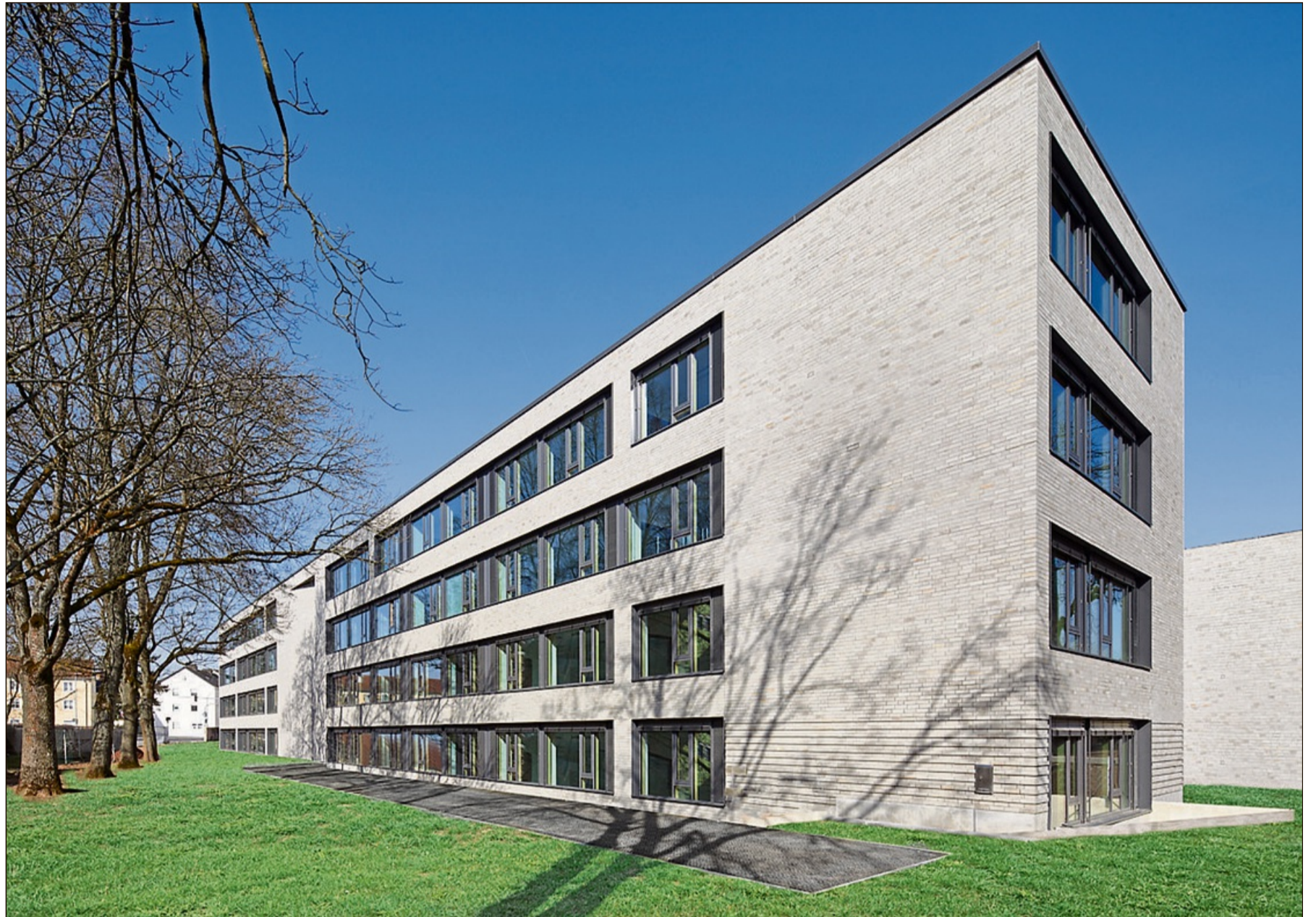
Mit einer klaren Formsprache schließt dieser Riegel das Schulensemble im Süden des Grundstücks ab.
